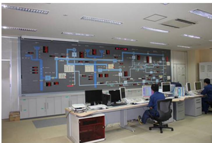
水運用センター 管理室
